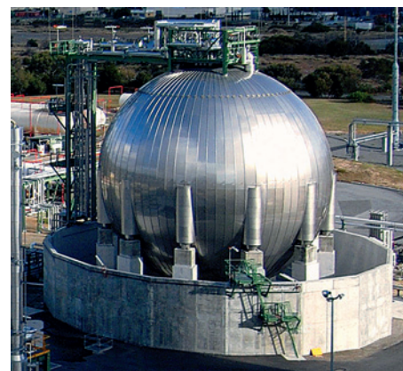
Example 3: LNG storage tank in Kwinana
