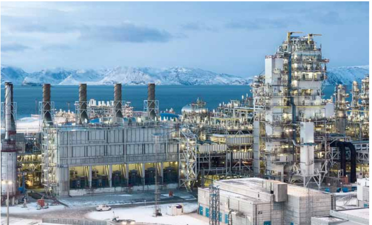
LNG plant, northern Norway
