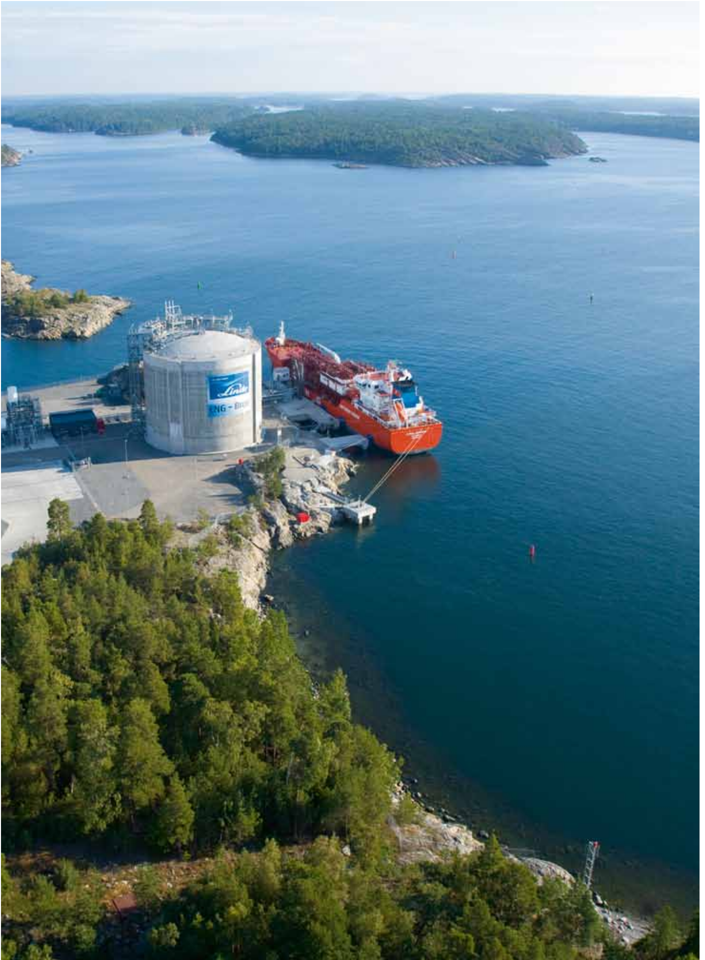
LNG storage tank at LNG terminal in Nynäshamn, Stockholm, Sweden.
